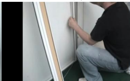
11. Vložte do rámu 2. bočný profil
