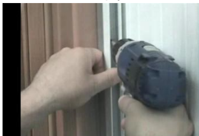
10. Vložte do rámu 1. bočný profil a priskrutkujte ho
