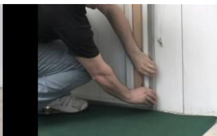
14. Zatlačte ho do bočného profilu, tak aby rukoväť smerovala do stredu
